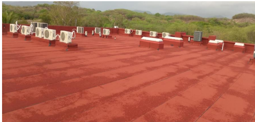
Img. 34 Techo de la unidad académica departamental
